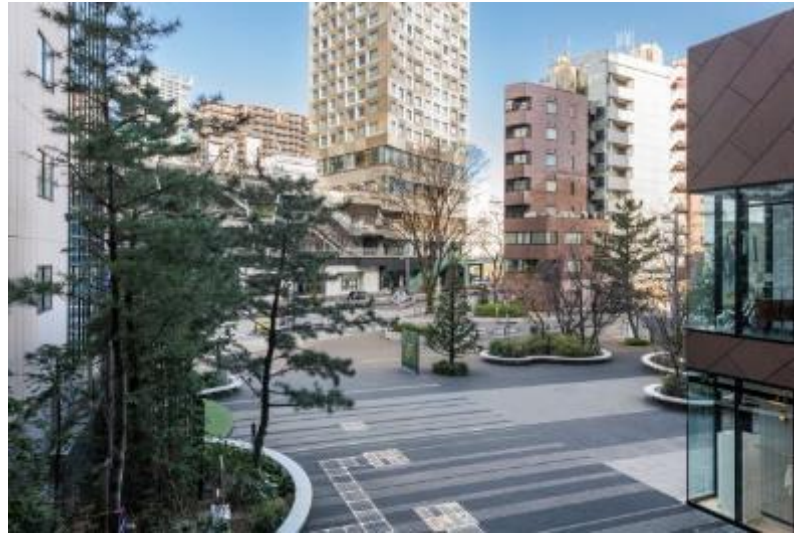
⑥大階段方面（上）から見た広場
